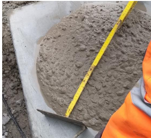
Bild 1 Ermittlung des Ausbreitmaßes im Ausbreitversuch auf der Baustelle
